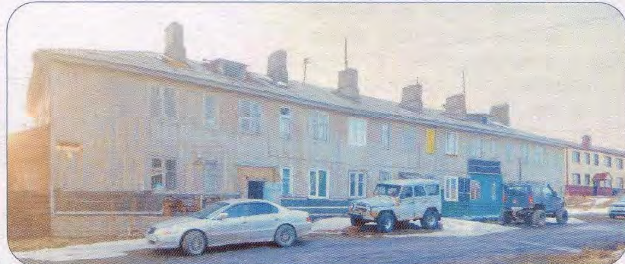
Аварийный дом по ул. Юбилейная, 2а
