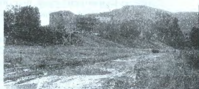
Конец 70-х. Строительство нового РДК
