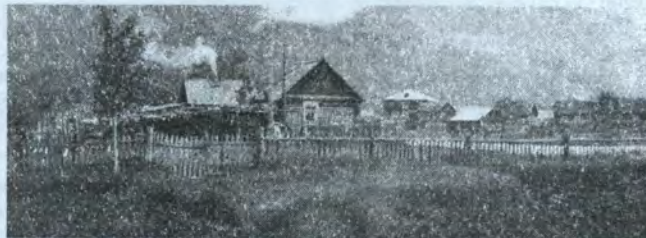
1966 год. Угол ул. Набережной. На заднем плане видно здание школы
