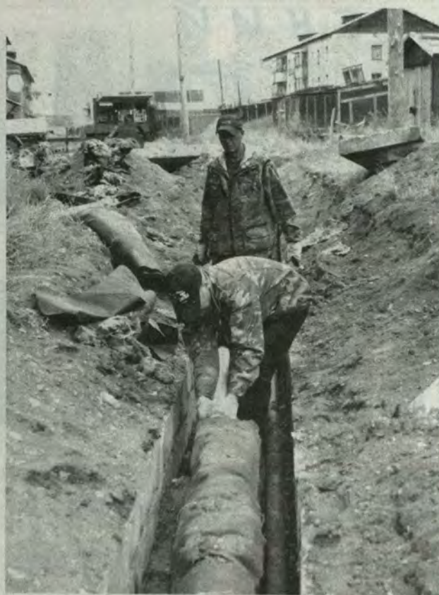
Оссора: плановый ремонт теплотрассы.
