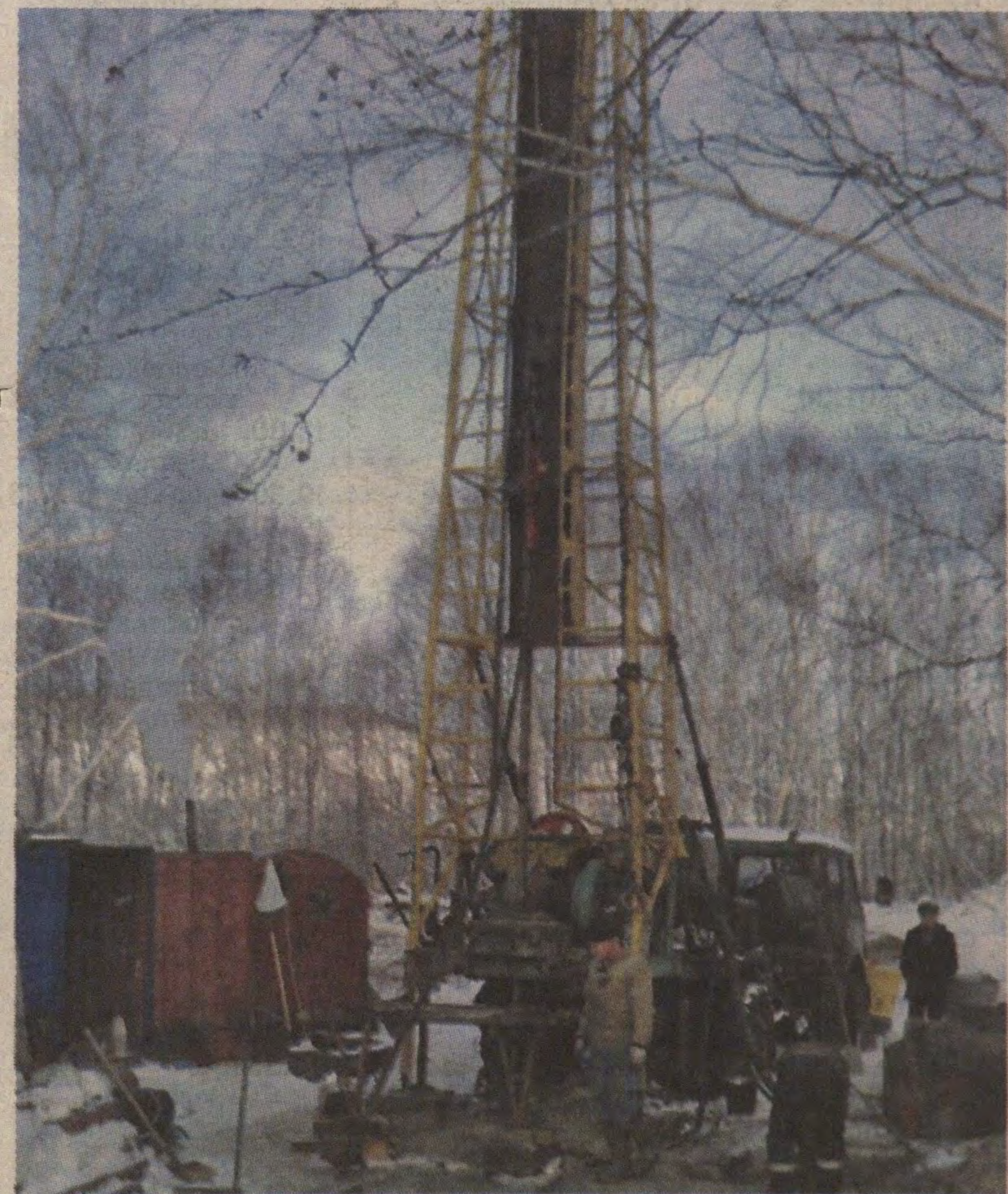
Бурение скважины для нового водозабора.
